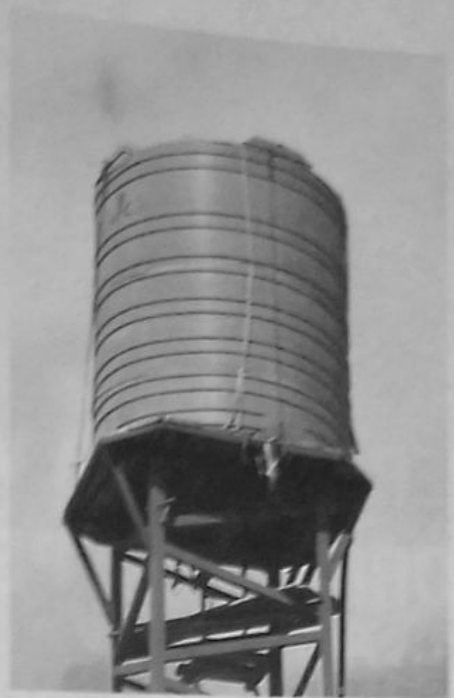
Fig. 32 - Depósito de água.
