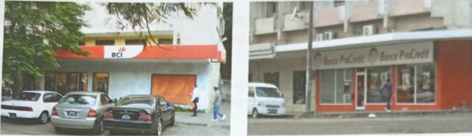
Fig. 4 Fachadas de instituições bancárias
