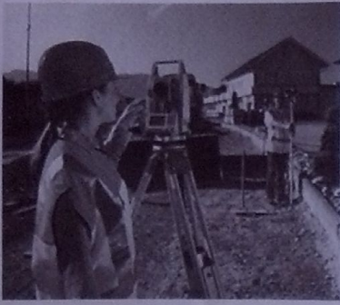
Um fotógrafo usa o Teodolito para medir o ângulo e fazer alinhamentos.
