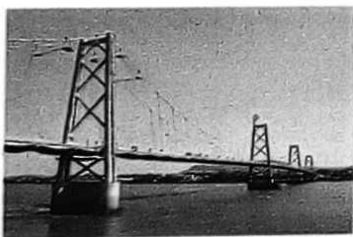
Fig. 6.12 Embora não sejam perceptíveis, os movimentos periódicos também se produzem na estrutura de uma ponte.
