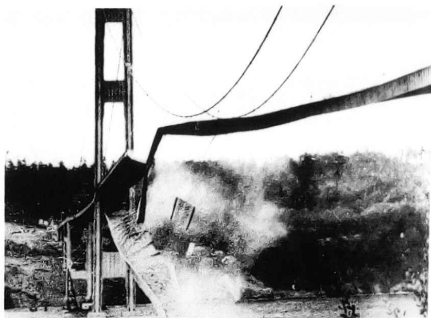
Colapso da ponte Tacoma Narrows, nos Estados Unidos, devido a um fenómeno de ressonância
