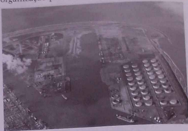
Fig. 21 Complexo industrial moderno.
