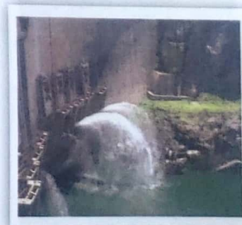
Fig. 15 Barragem de Cahora-Bassa
