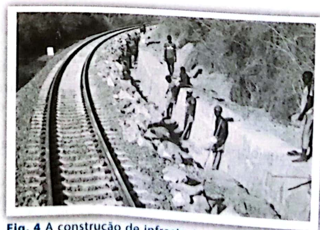
Fig. 4 A construção de infraestruturas era geralmente feita com uso do trabalho forçado.
