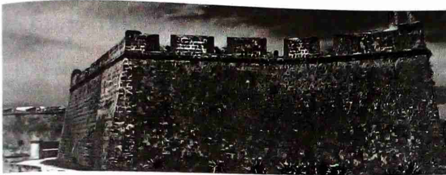
..... Fig. 17 Fortaleza da ilha de Moçambique, uma das primeiras fortalezas a serem construídas em Moçambique pelos Portugueses.
