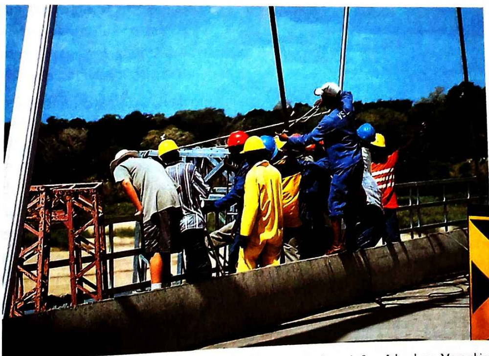
Obras numa ponte sobre o rio Save, Inhambane, Moçambique
