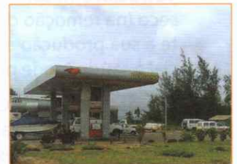
Fig. 12 Bombas de combustíveis
